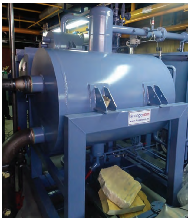
Slika 3 Kondenzator i isparivač dizalice topline
