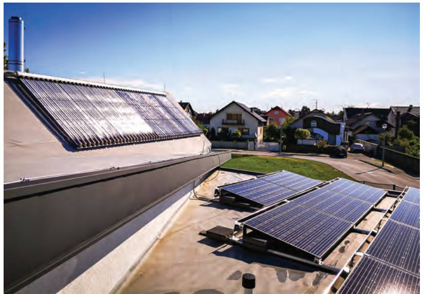
Slika 3 Solarni kolektori i fotonaponska elektrana na krovu kuće
